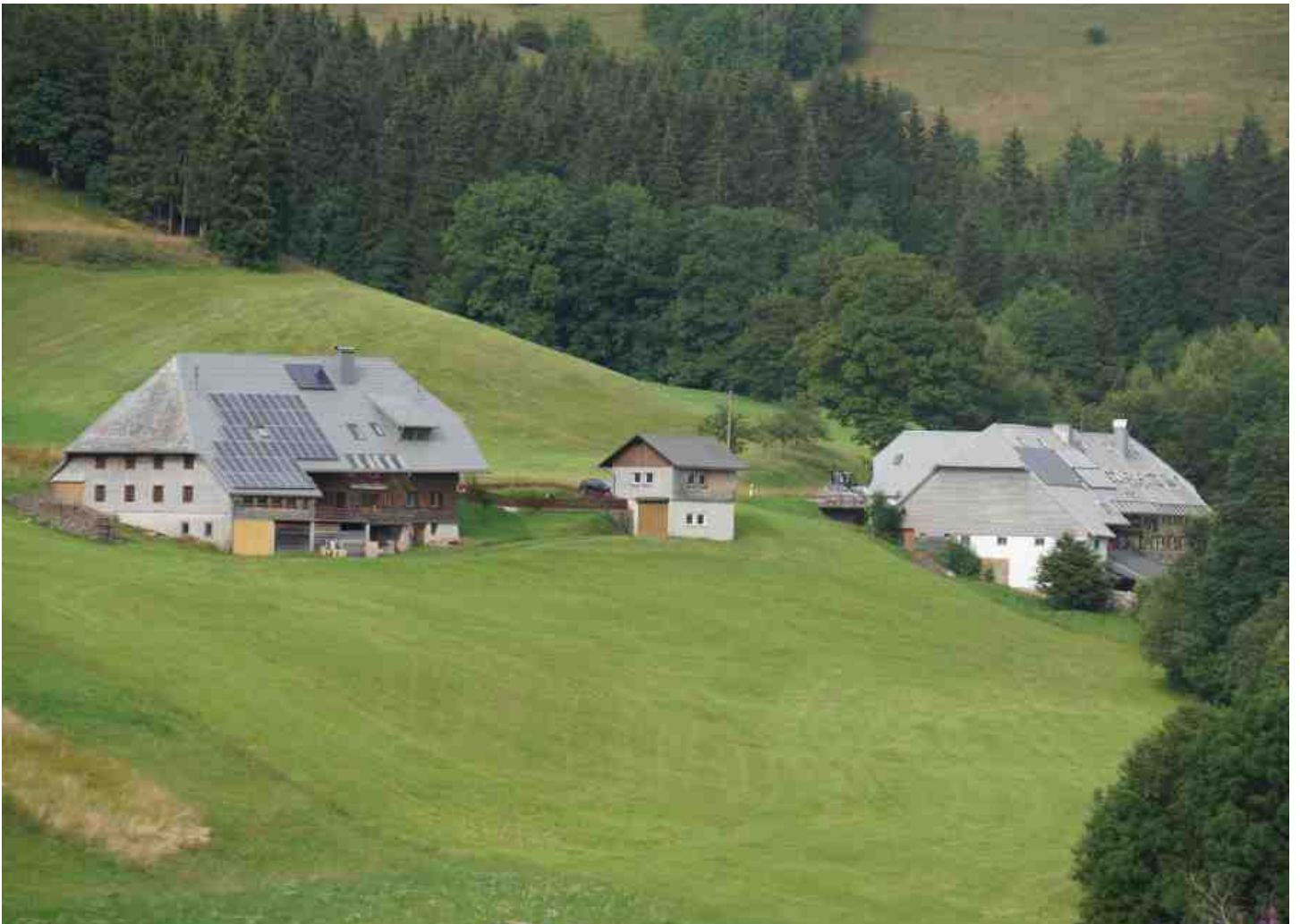
Bild oben: Viele Schwarzwaldhöfe stehen hangparallel, unterhalb der Straße, sie haben eine Vorderseite mit dem Wohnteil und einem kleinen umzäunten Garten und eine Rückseite mit dem Wirtschaftsteil und einer Hocheinfahrt. Die Grundstücke sind meist nicht von Zäunen begrenzt.
